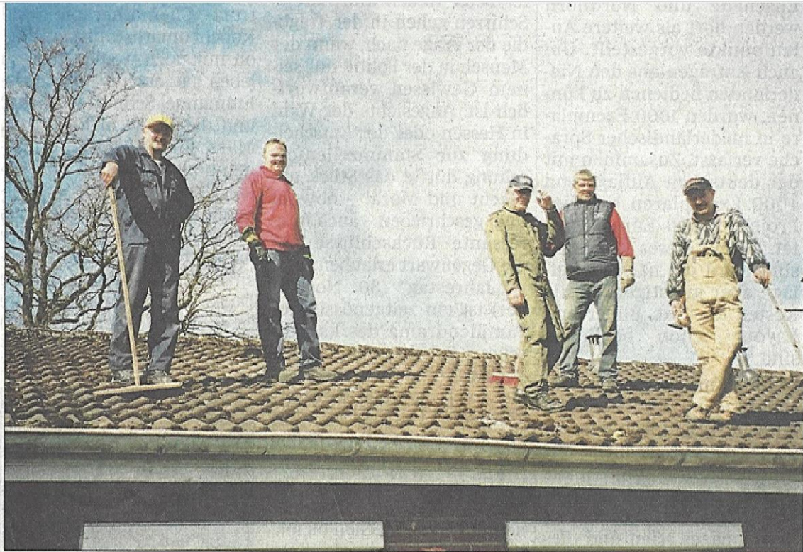
Eine schweißtreibende Arbeit verrichteten Mitglieder des Lager Gemeinderats beim „Tag für unser Dorf“. Die Männer isolierten das Dach des Kindergartens. Foto: Privat
