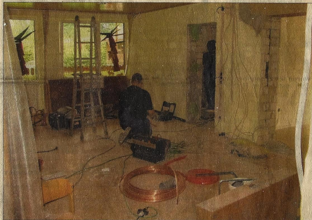
Noch vor wenigen Tagen waren Arbeiter mit dem Verlegen von Kabeln beschäftigt. Ab heute spielen hier wieder Kinder. Foto: Zirkel
